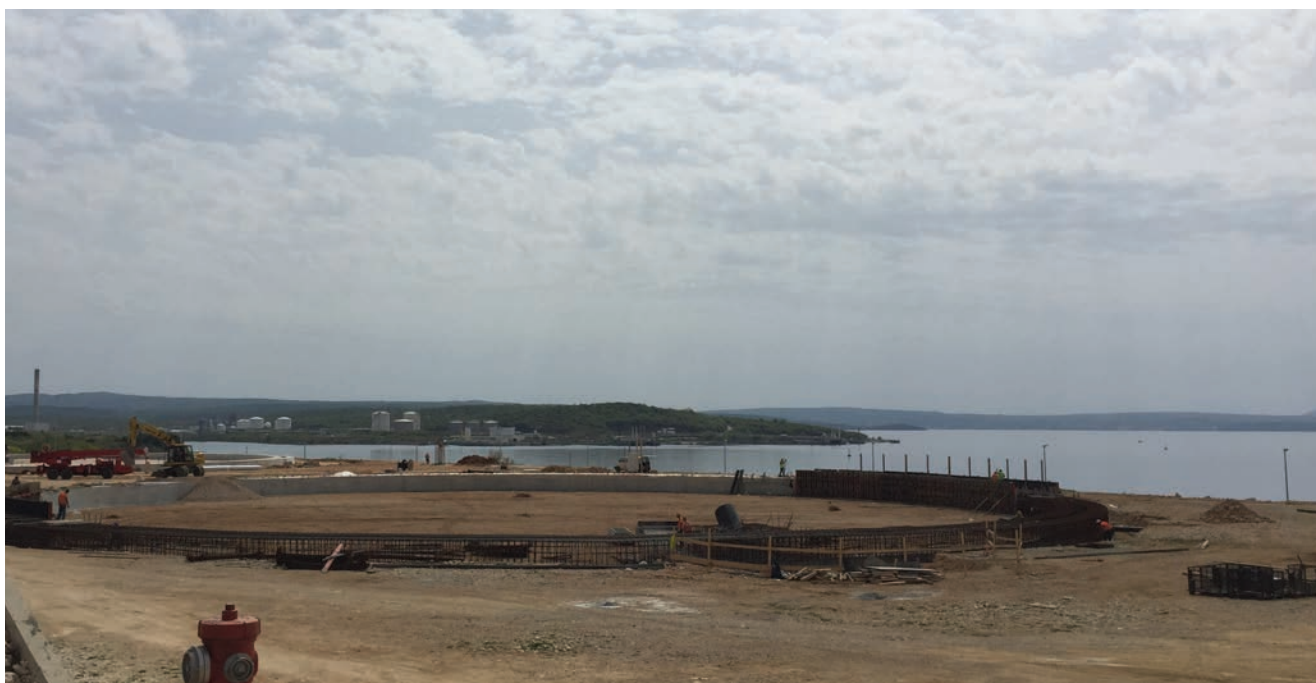
Detalj s gradilišta novih spremnika za naftne derivate
