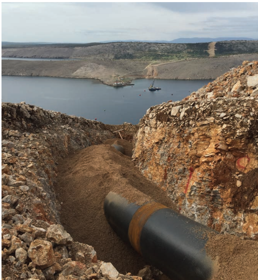
Detalj s gradilišta
