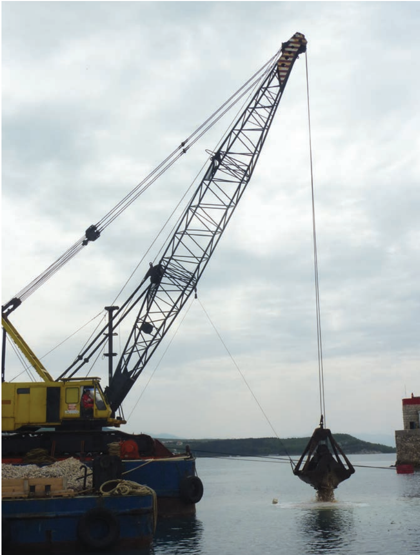
Pogled na gradilište
