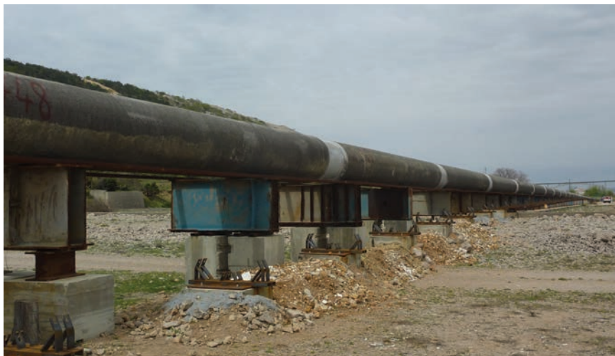
Cijevi s betonskim omotačem spremne za polaganje u more
