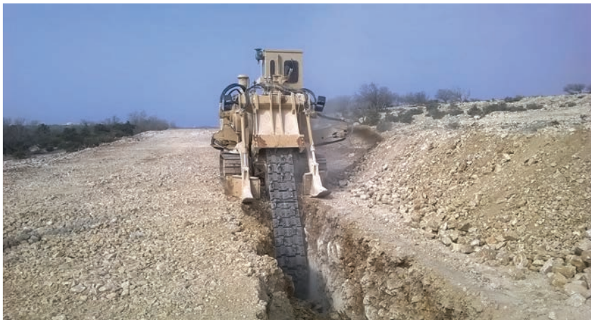
Radovi na iskopu
