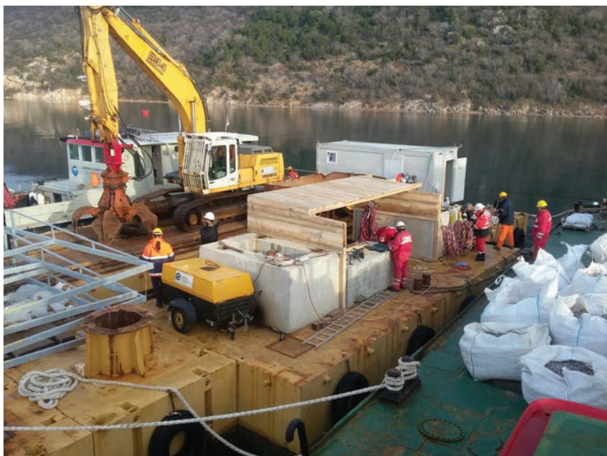
Plovna oprema za izvođenje podmorskih radova
